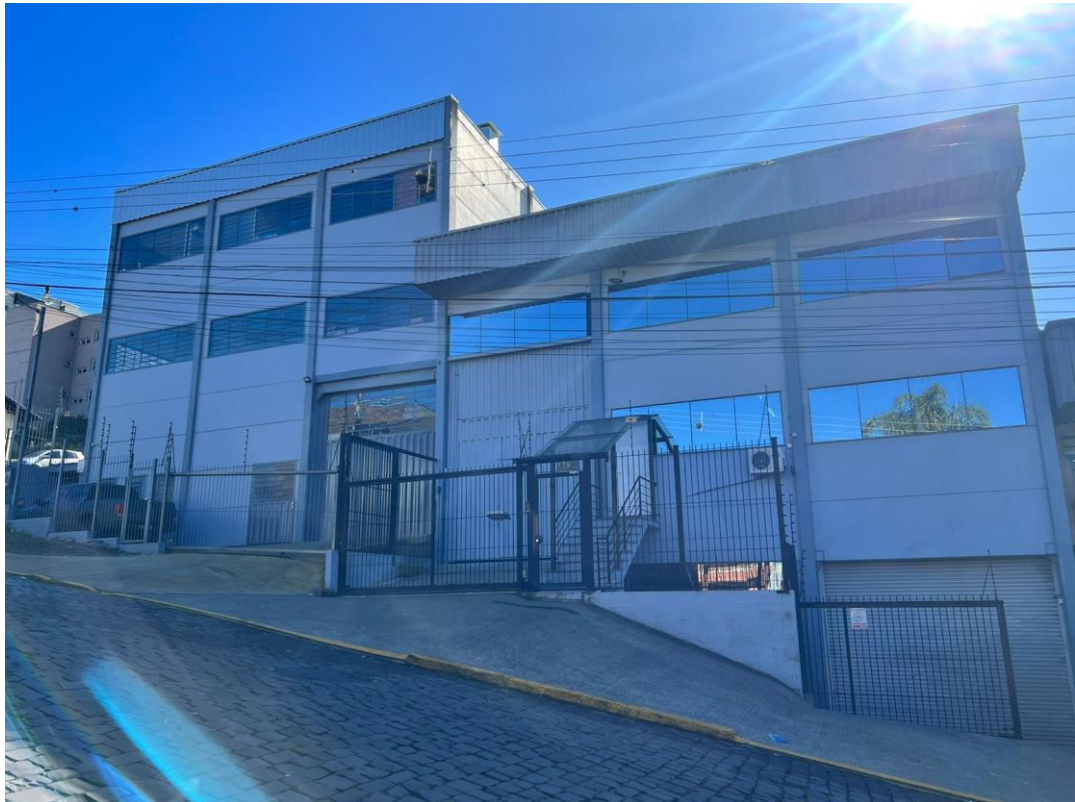
Figura 2 – Fachada da GBL Distribuidora.
