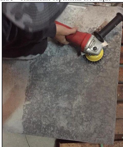
Figura 5 - Tratamento superficial escovação
