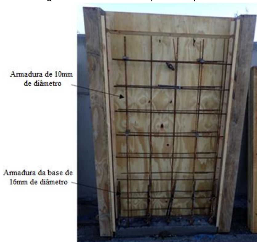
Figura 14 – Armadura do painel de parede.
