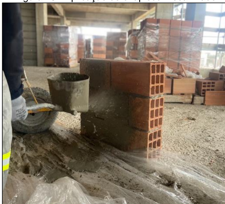
Figura 18 - Aplicação de chapisco mecanizado
