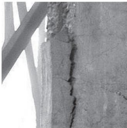
Figura 7 - Efeito spalling
