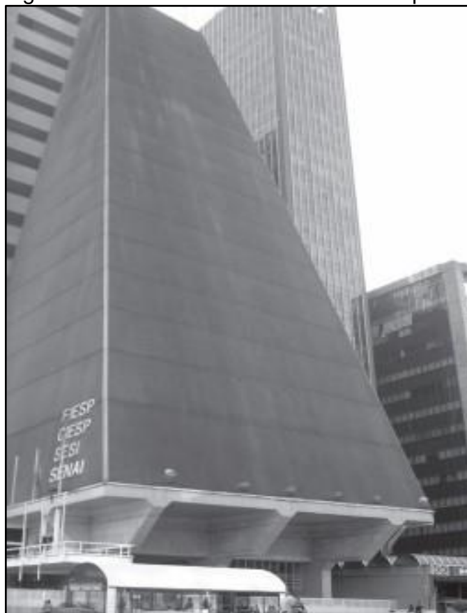
Figura 2 – Estrutura de concreto armado pronta
