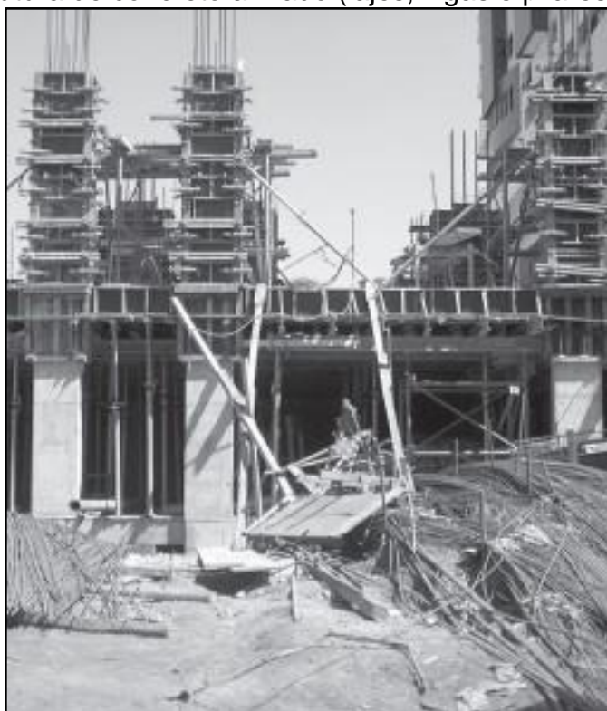
Figura 1 – Estrutura de concreto armado (lajes, vigas e pilares) em construção
