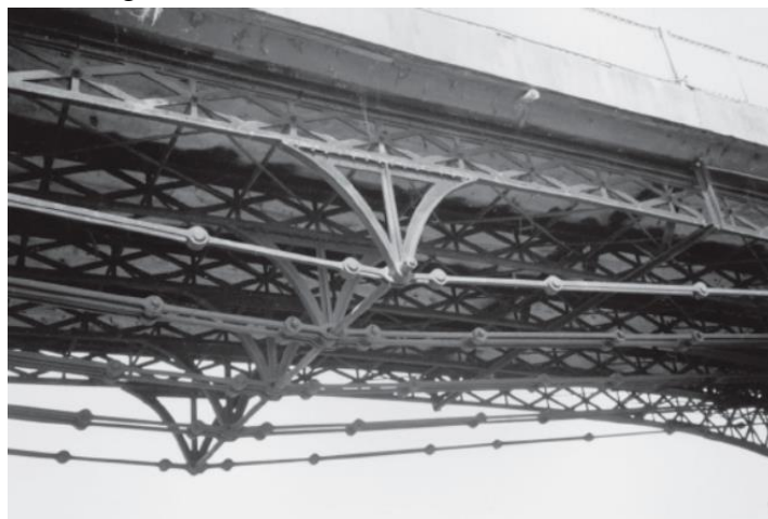
Figura 3 – Ponte sobre o rio Paraíba do Sul
