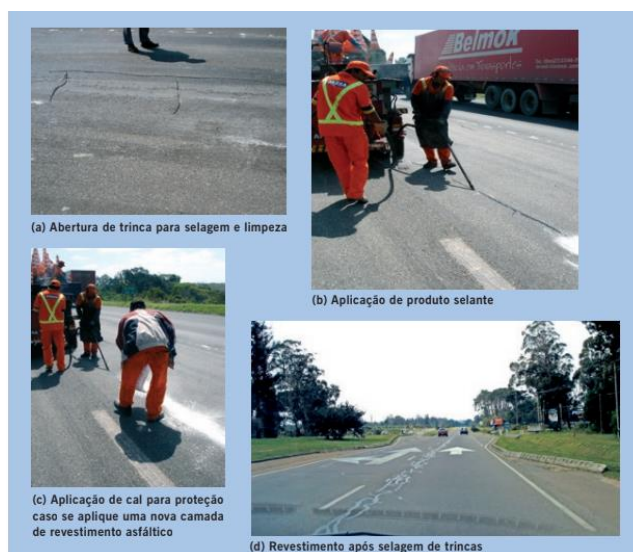
Figura 23 - Exemplo de selagem de trincas
