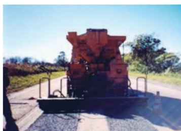
Figura 26 - Aplicação do MRAF para o preenchimento de trilhas de roda
