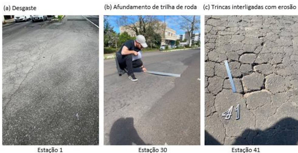
Figura 52 - Principais manifestações patológicas detectadas no trecho
