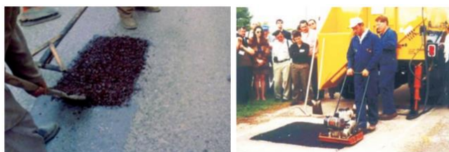
Figura 22 - Aplicação e compactação de PMF
