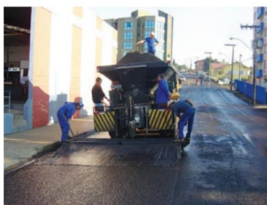
Figura 24 - Aplicação de lama asfáltica
