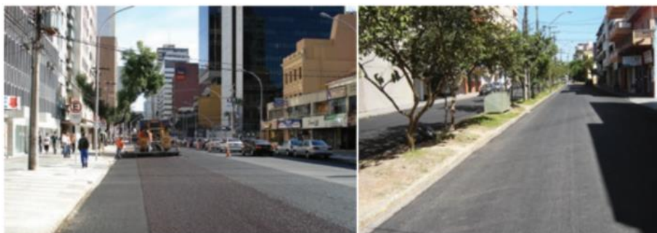
Figura 27 - Microrrevestimento asfáltico em vias urbanas
