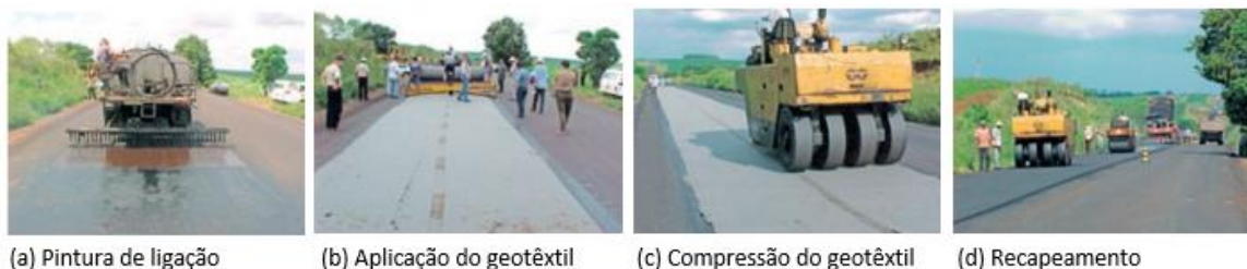
Figura 33 - Aplicação de geotêxtil em restauração de revestimento asfáltico
