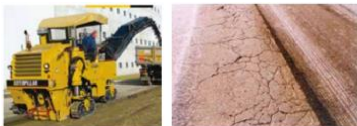
Figura 34 - Fresagem no pavimento asfáltico
