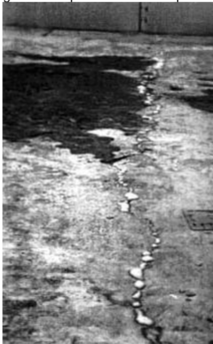
Figura 1- Fotografia do reparo realizado na ponte com o adesivo
