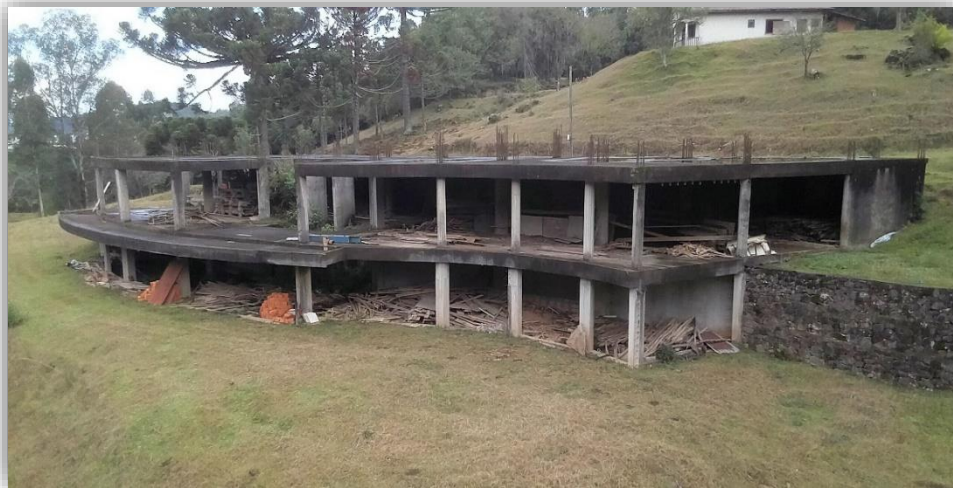
Figura 14 – Foto atual do empreendimento
