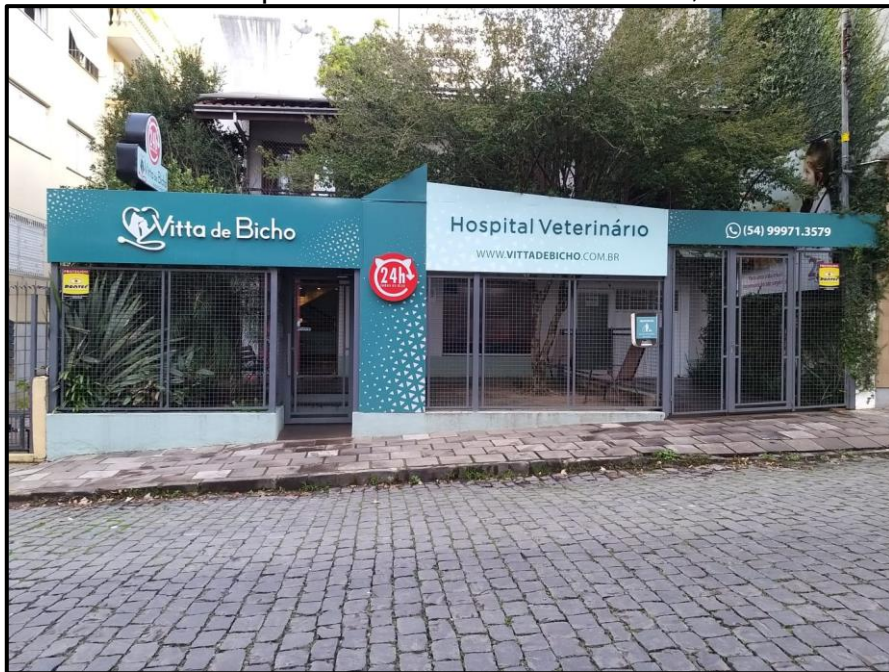
Figura 1 - Fachada do Hospital Veterinário Vitta de Bicho, em Caxias do Sul/RS.
