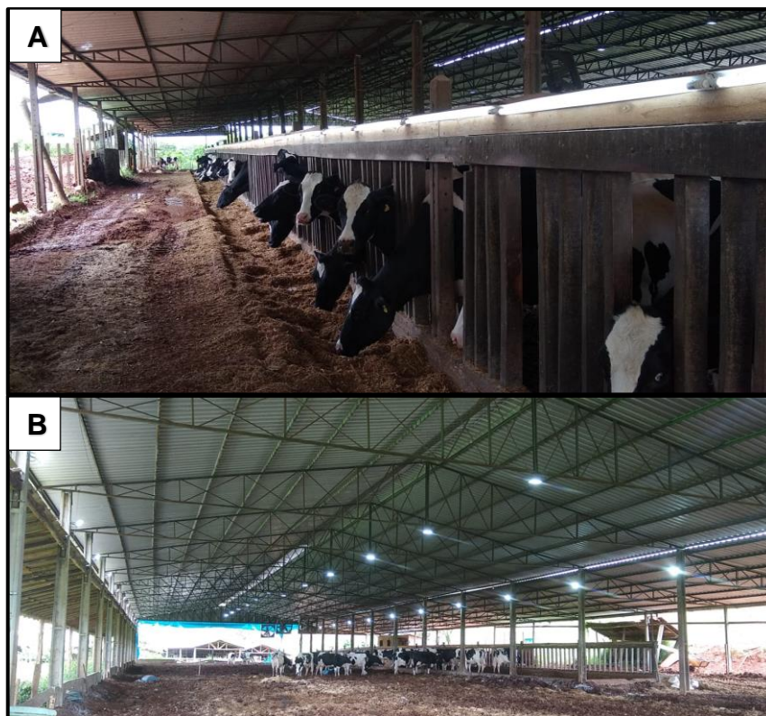
Figura 14 – Iluminação. A) Iluminação artificial em linha de cocho. B) Iluminação artificial em extremidades laterais e nos pontos centrais do galpão.
