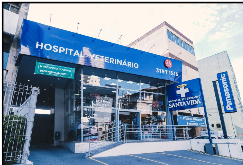
Figura 17 – Fachada do Hospital Veterinário Santa Vida - Estreito
