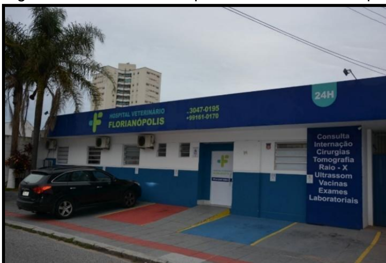
Figura 1 - Fachada do Hospital Veterinário Florianópolis
