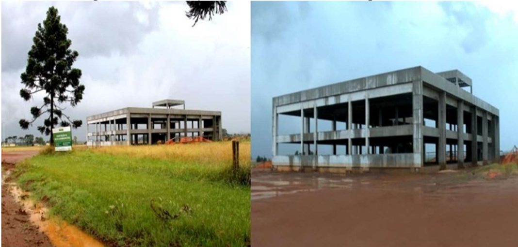
Figura 2 – Construção da sede do IFRS – Campus Vacaria
