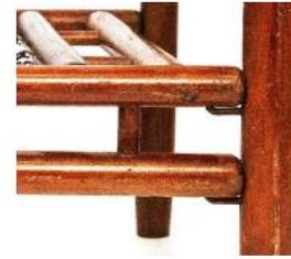
Figura 16 - Berço estilo Patente: detalhe do pino de encaixe do estrado
