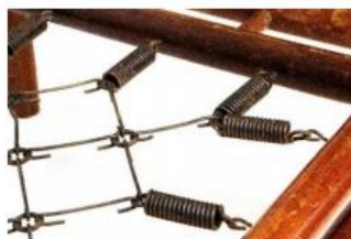
Figura 12- Detalhe da malha de molas do estrado
