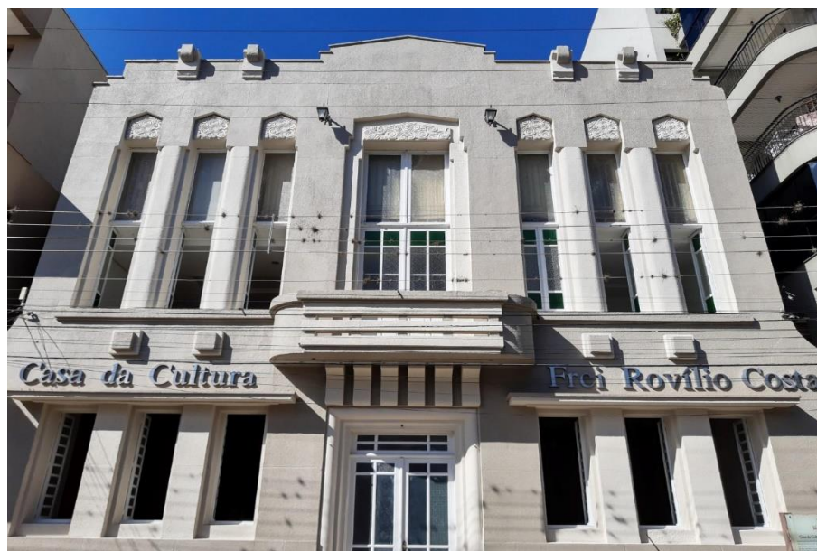
Figura 33 – Fachada atual da Casa de Cultura Frei Rovílio Costa, Veranópolis, RS
