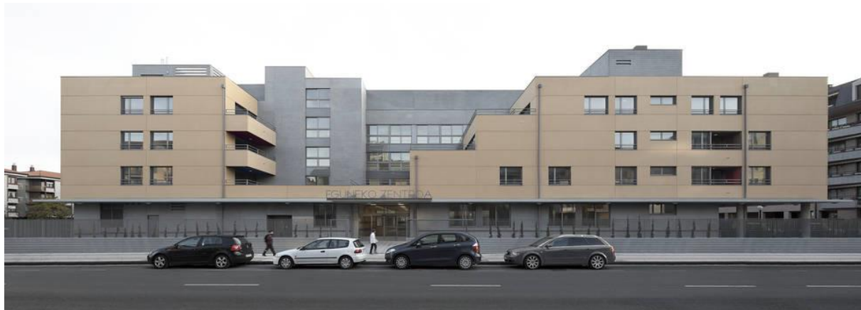
Figura 15 - Fachada Norte, apartamento para idosos e centro dia
