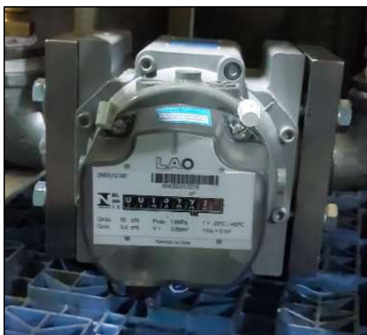
Figura 7 - Instalação medidor LAO G40
