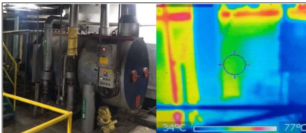
Figura 12 - Leitura da Temperatura do corpo da caldeira CAD-HP-1500
