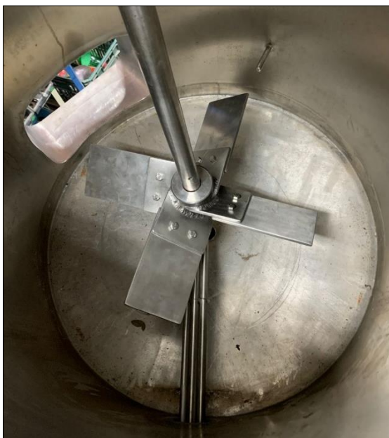
Figura 14 - Vista interna do reservatório
