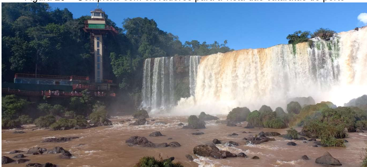
Figura 20 – Complexo com elevadores para a vista das cataratas de perto
