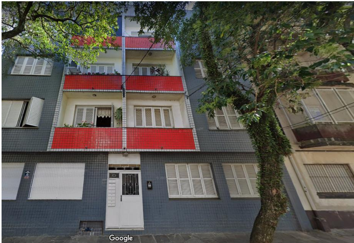
Figura 1 – Fachada da Alimentar Vet.
