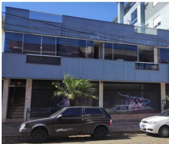
Figura 2 - Fachada do Call Center da Empresa Adyl Telecom
