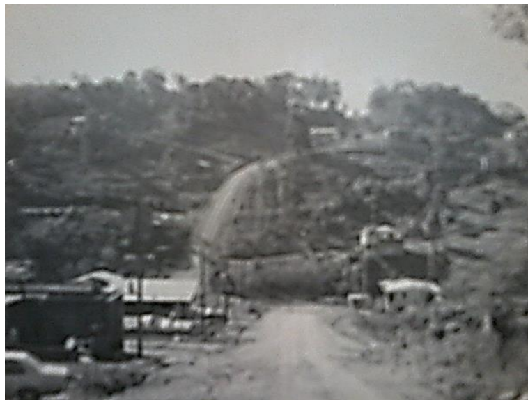
Fonte: Loteamento clandestino Jardim Vitória – Bairro São Cristóvão. Levantamento Loteamentos Irregulares – 2º semestre de 1985 - SDU
