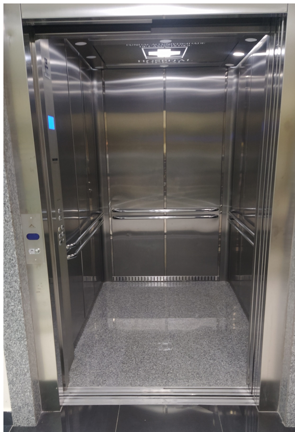
Figura 71 – Cabine do elevador utilizado para teste.
