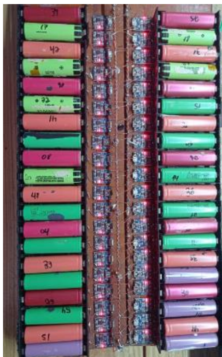
Figura 11 - Dispositivo de carregamento
