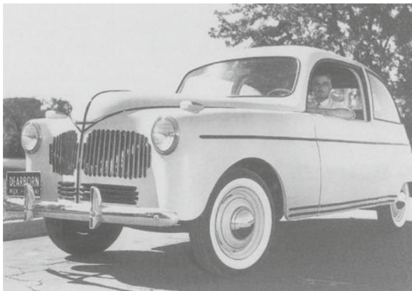
Figura 4 – Carroceria produzida a partir de biopolímero a base de soja
