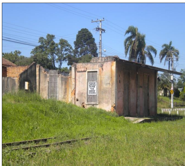
Figura 8 e 9– Ruínas da estação férrea do Bairro Desvio Rizzo, construída em 1938
