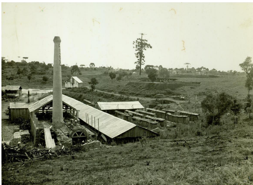
Figura 11– Preparação de tijolos para a construção do Frigorífico Rizzo. Autoria: Giacomo Geremia. Local: Desvio Rizzo - Caxias do Sul, 1930.
