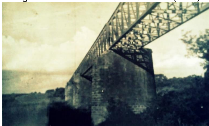
Figura 11 – Ponte sobre o Rio Piratini (1898)
