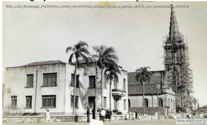
Figura 17 – Igreja Matriz em construção na década de 1940
