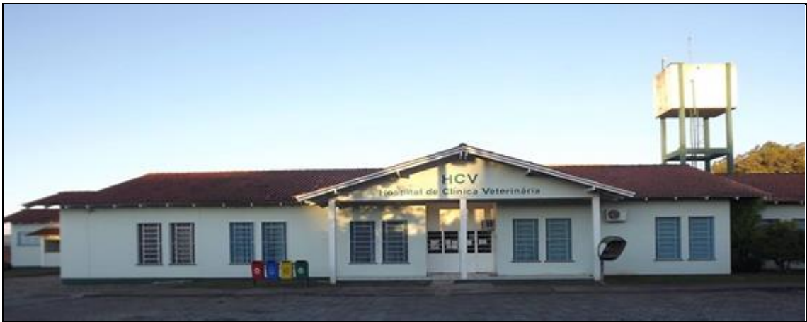
Figura 1 – Parte externa do Hospital de Clínica Veterinária do Centro de Ciências Agroveterinárias (CAV) da UDESC
