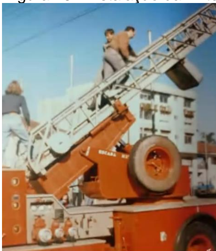
Figura 26 - Instalação da Antena
