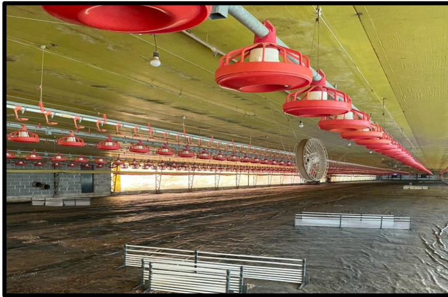
Figura 10- Enlonamento da cama
