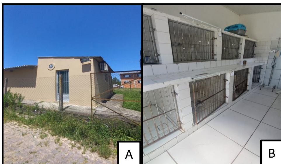
Figura 16 – Internação de isolamento do Hospital de Clínicas Veterinária da Universidade Federal de Pelotas/RS. A) Estrutura externa. B) Interior da internação.
