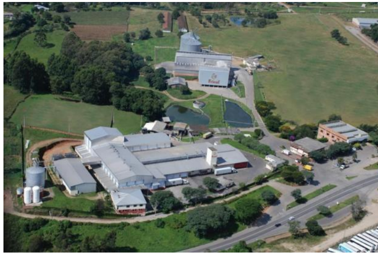
Figura 2 – Antiga Frinal antes de ser comprada pela JBS S.A. A planta da unidade continuava a mesma
