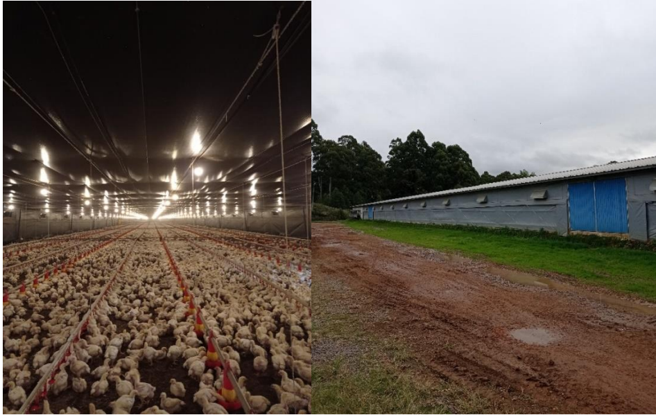
Figura 4 – Área interna e externa do sistema Climatizado
