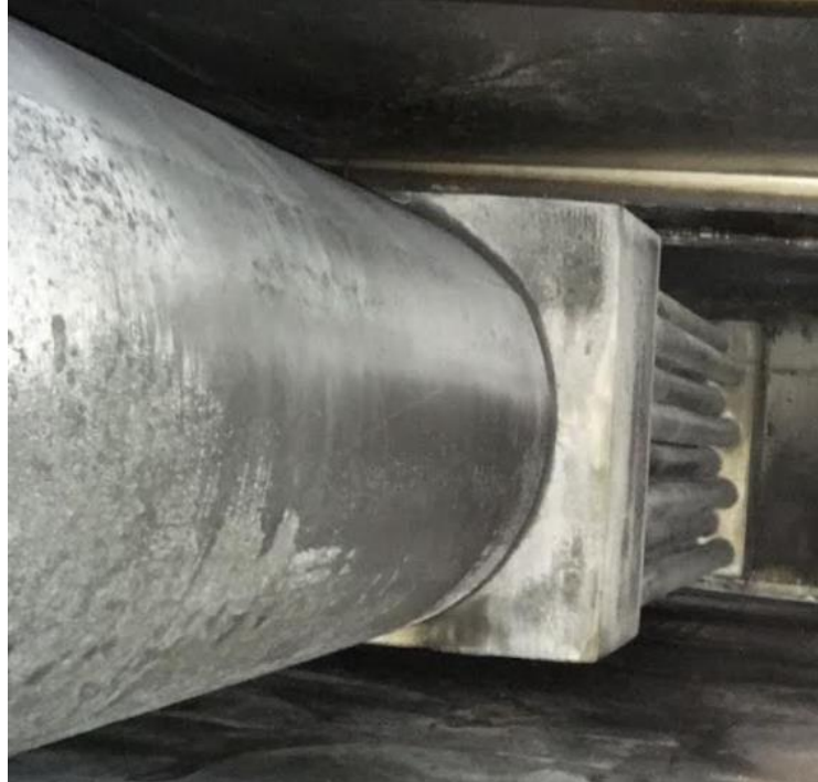
Figura 9: Túnel de aquecimento.
