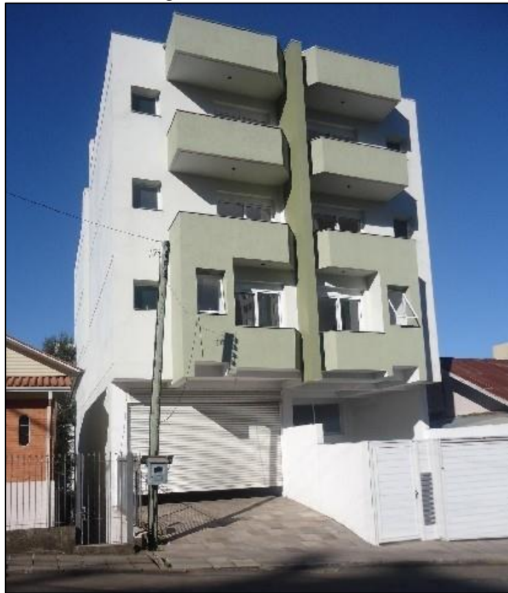
Figura 39 - Fachada do mercado
