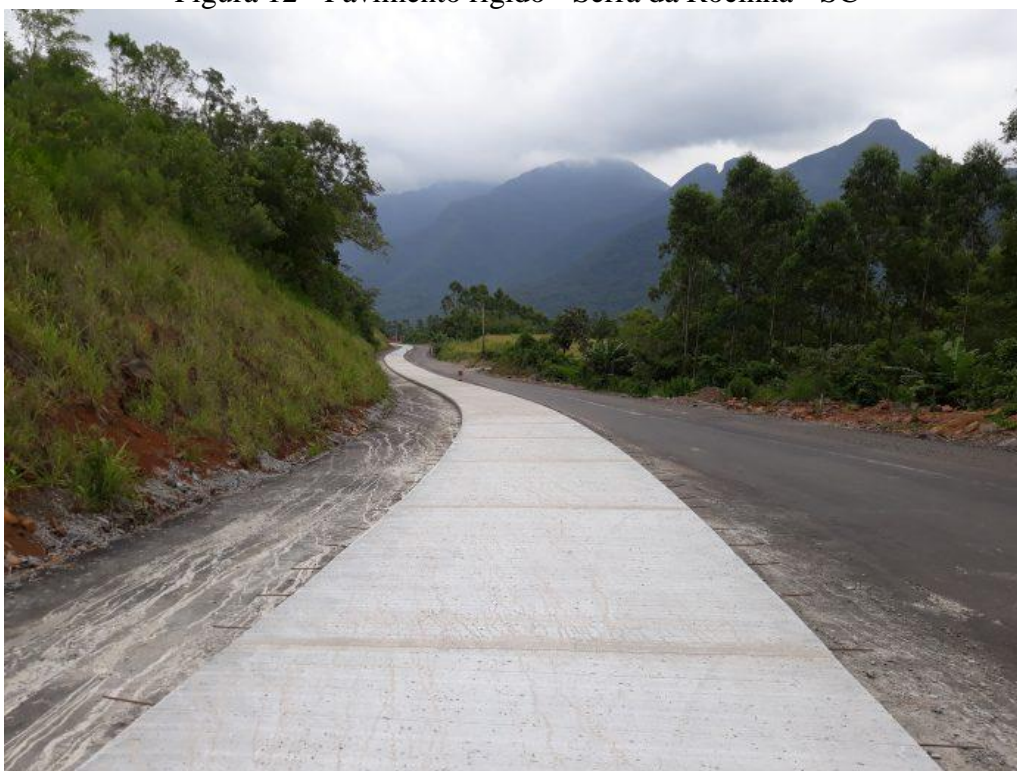
Figura 12 - Pavimento rígido - Serra da Rocinha - SC
