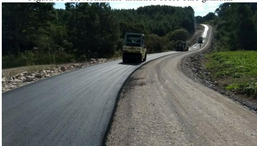
Figura 11- Revestimento asfáltico sobre base granular
