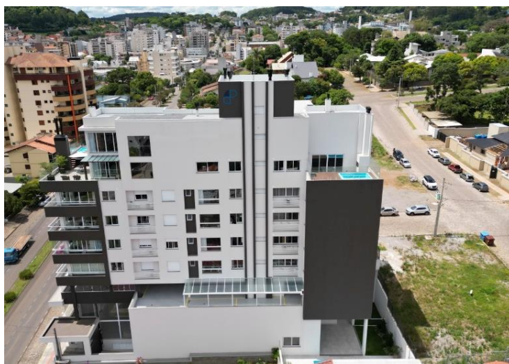
Figura 12 - Edificação A – Fachada Sul
