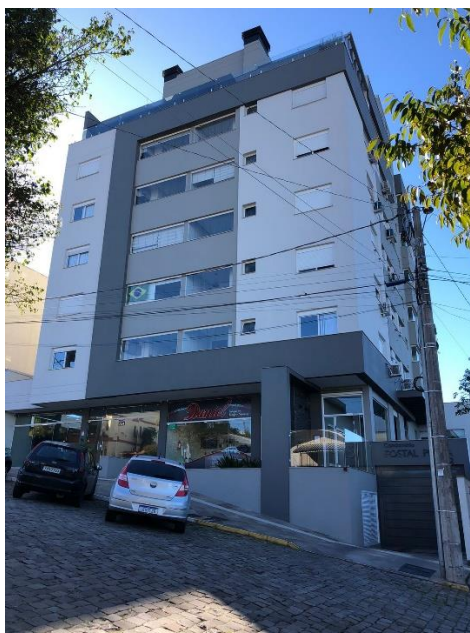
Figura 15 - Edificação B - Fachada Sul
