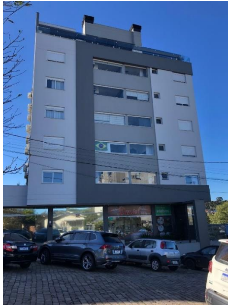
Figura 16 - Edificação B - Fachada Oeste
