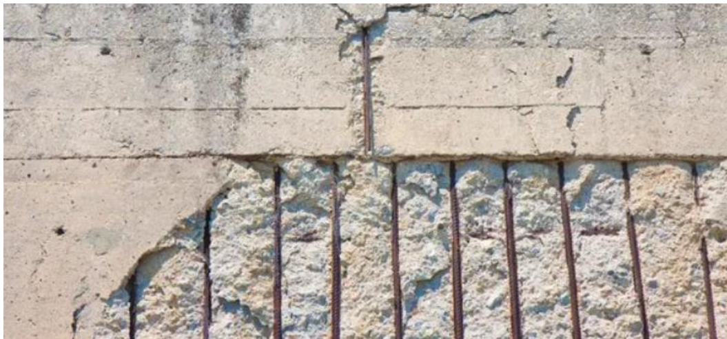
Figura 7 - Corrosão
