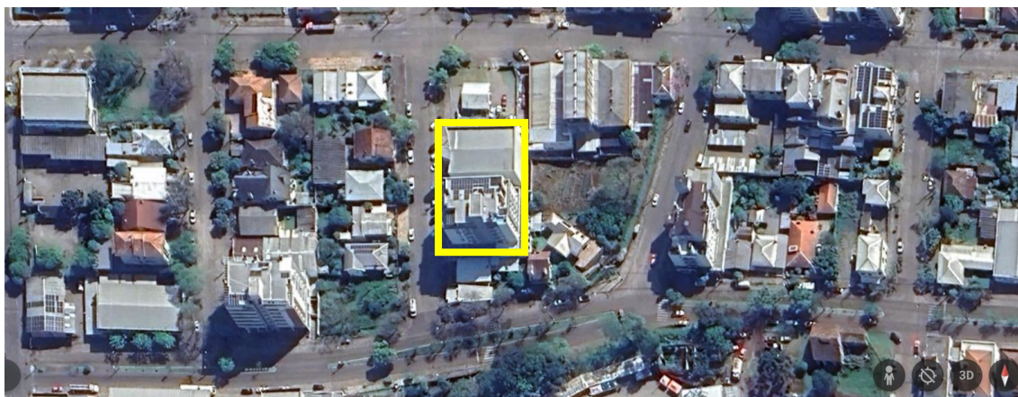
Figura 14 - Edificação "B"- vista aérea
