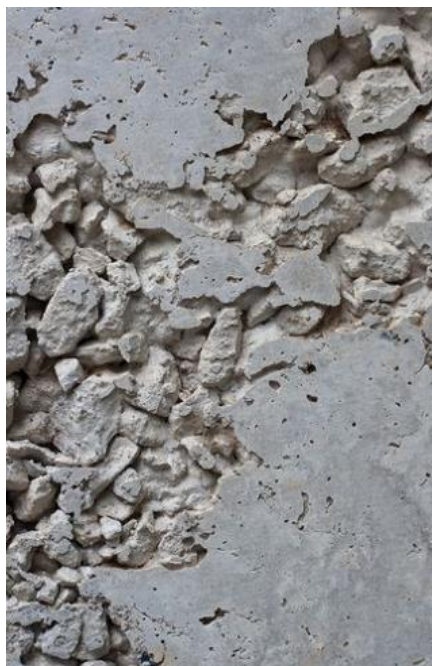
Figura 5 - Desagregação
