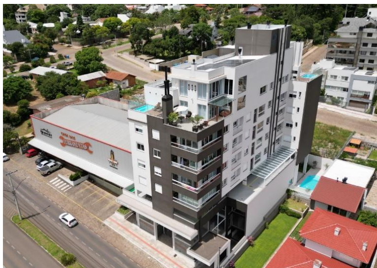
Figura 13 - Edificação A - Fachada Oeste
