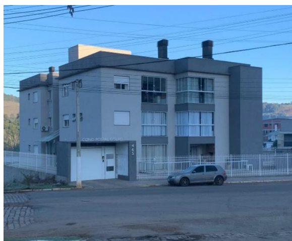
Figura 18 - Edificação C - Fachada Oeste
