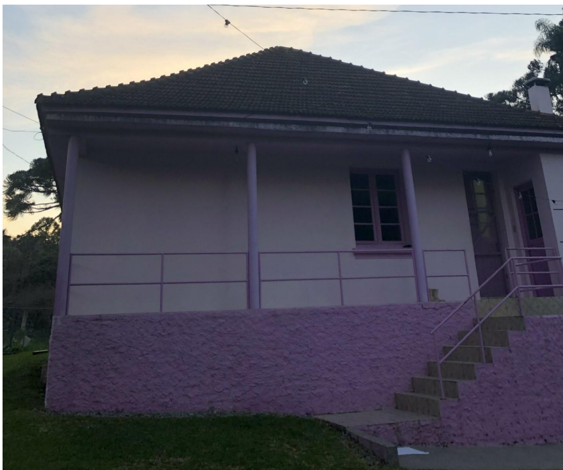
Figura 32 - Vista da fachada leste da Residência 04
