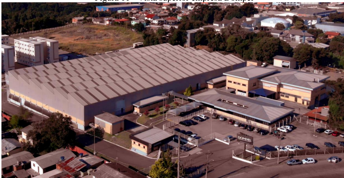
Figura 11 - Vista superior empresa Dompel
