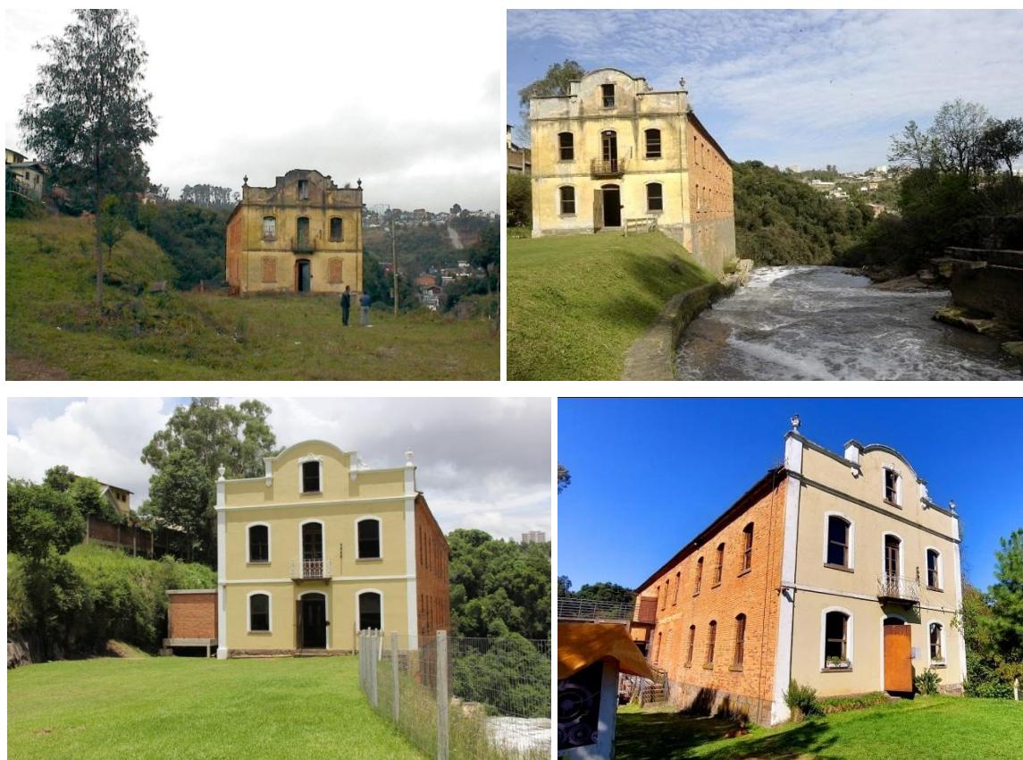
Figura 130 a 133: Moinho da Cascata antes e depois da reforma.
