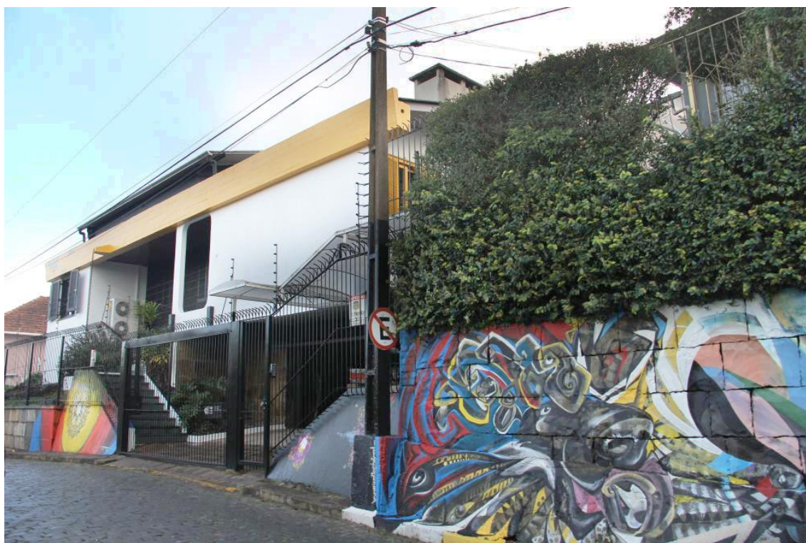
Figura 111: Visão externa da nova sede.
