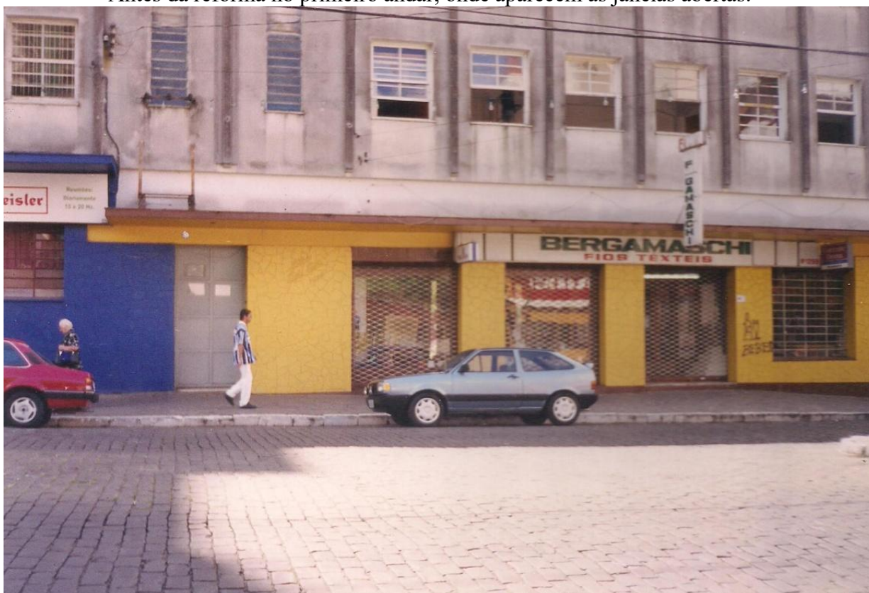
Figura 104: Sede da Tem Gente Teatrando na Júlio de Castilhos, 1.259, Centro. Antes da reforma no primeiro andar, onde aparecem as janelas abertas.
