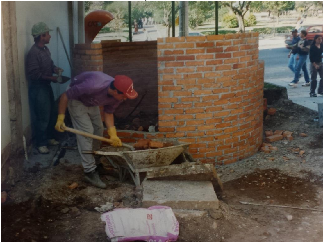
Figura 16: Reforma Teatro Municipal da Casa da Cultura . Edificação da bilheteria.
