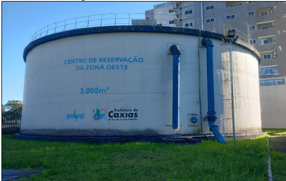
Figura 4 – Reservatório da Zona Oeste
