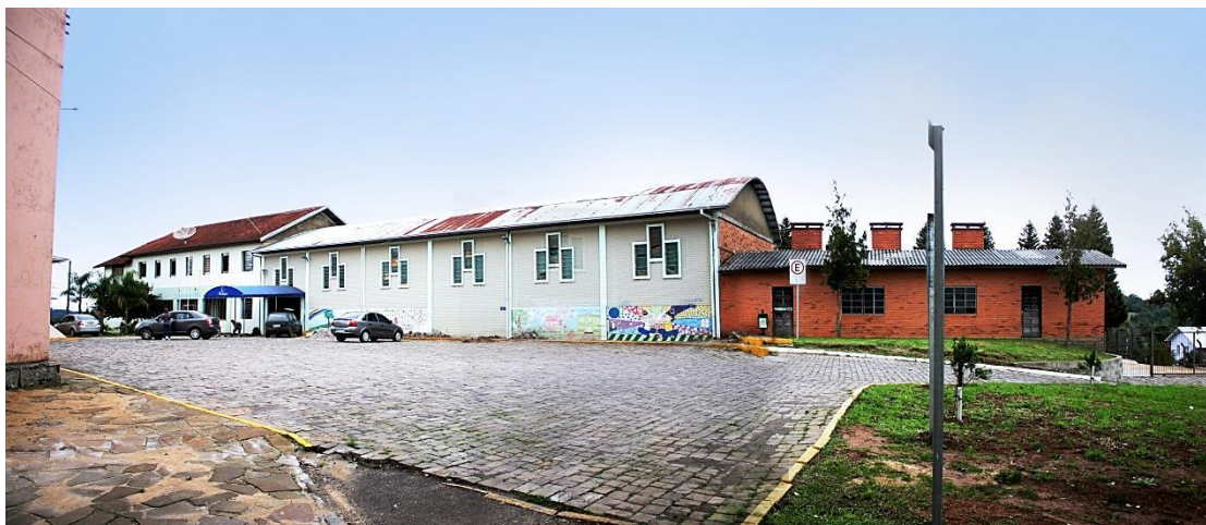
Figura 44- Fachada da Escola Santa Lúcia, vista a partir do pátio dos fundos da igreja.
