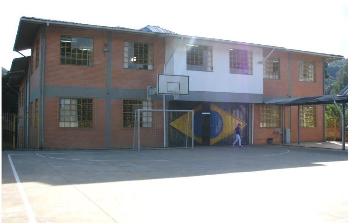
Figura 57- Detalhe da Fachada do prédio.
