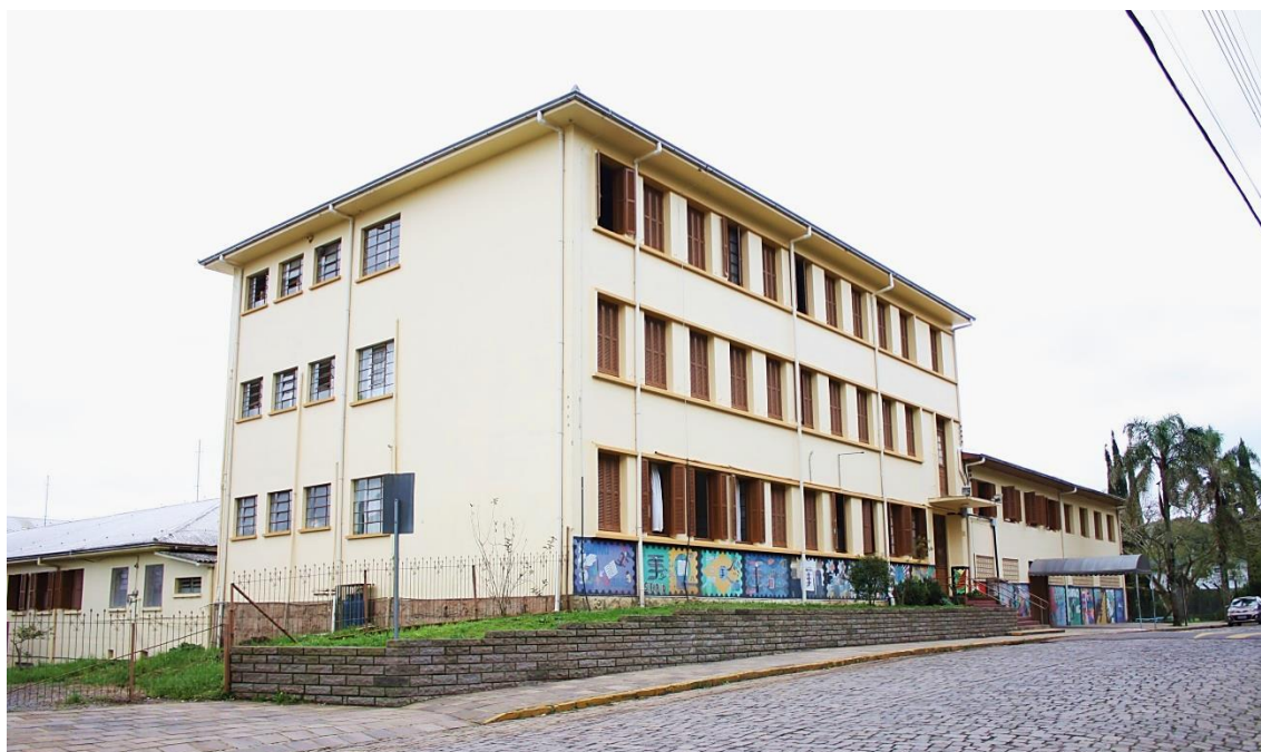
Figura 33- Escola Municipal de Ensino Fundamental Pe. João Schiavo. Fachada a partir da rua de acesso.
