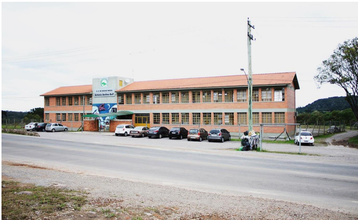
Figura 48- Fachada Avelino Antônio Boff em detalhe.
