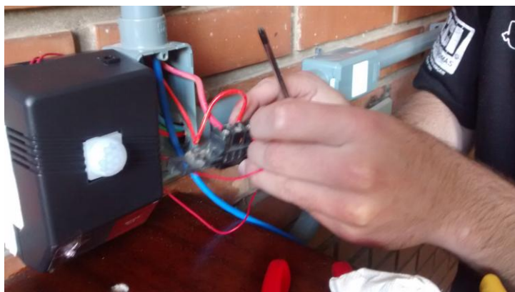
Figura 31: Instalação do Módulo Relé.
