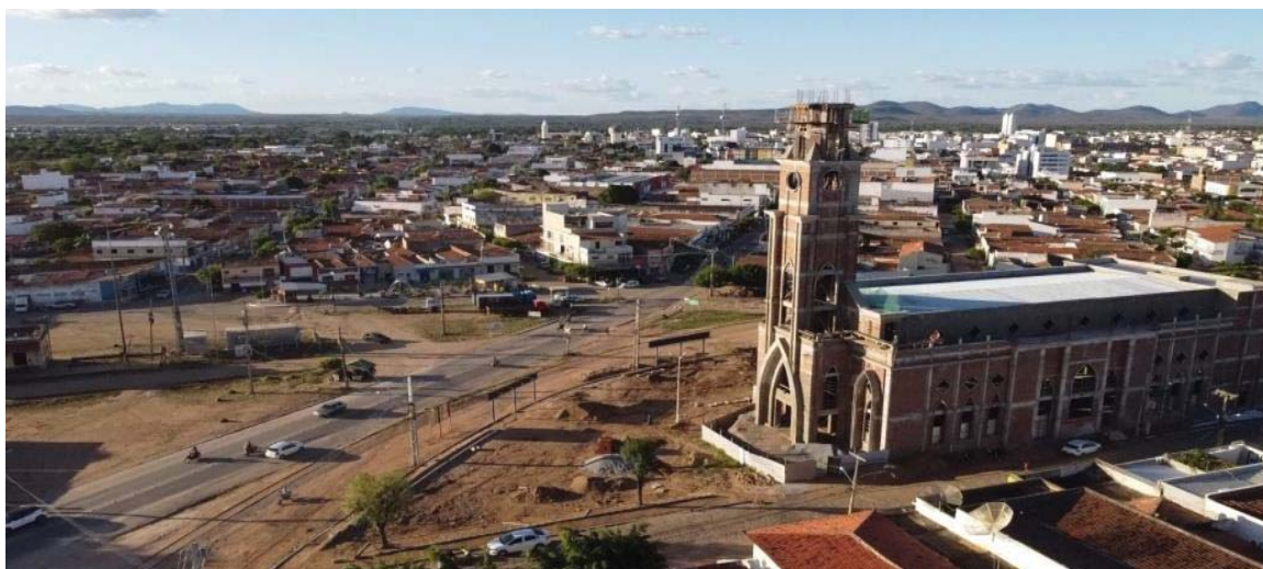
Figura 7: Construção da Igreja Matriz de Sant' Ana em Sousa-PB
