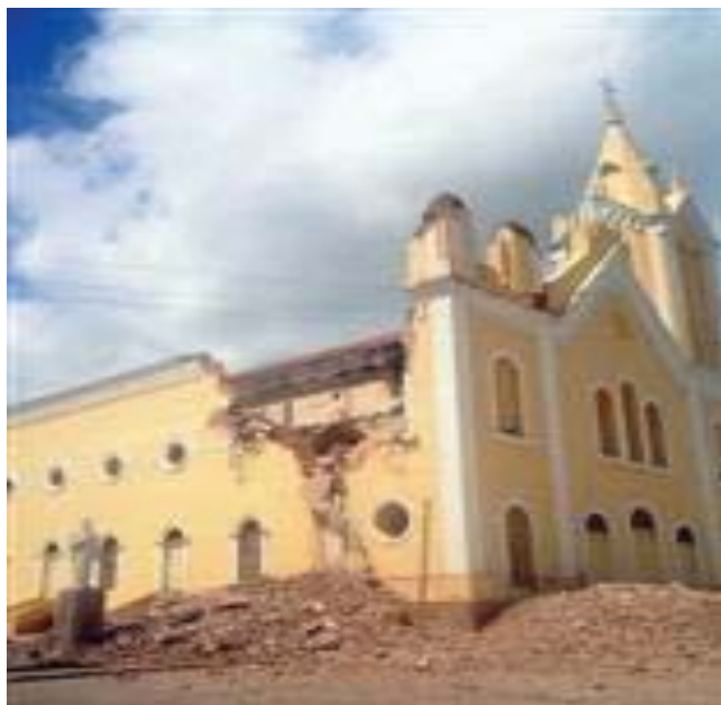
Figura 5: Igreja Nossa Senhora dos Remédios após queda da torre
