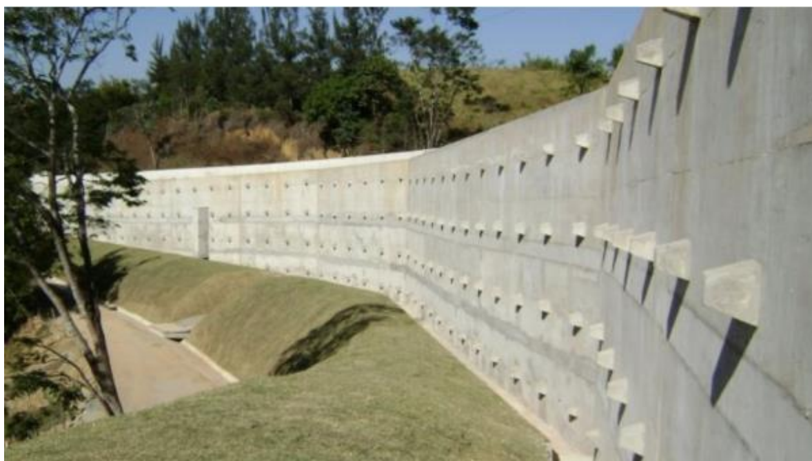
Figura 2 - Cortina atirantada já executada
