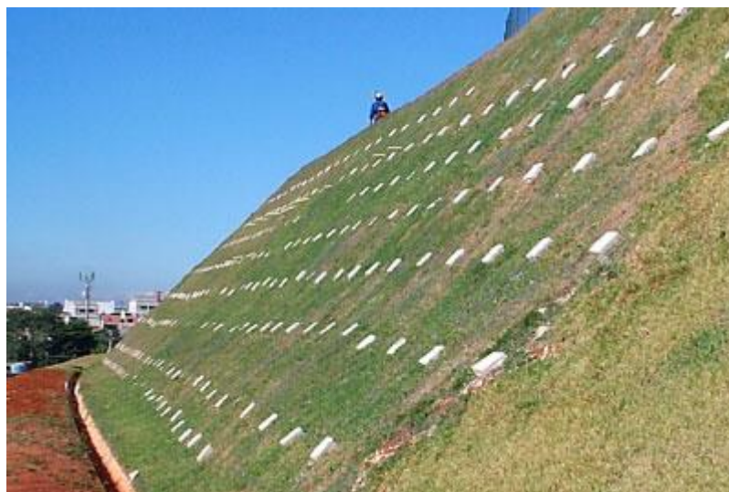
Figura 9 - Solo grampeado com cobertura vegetal
