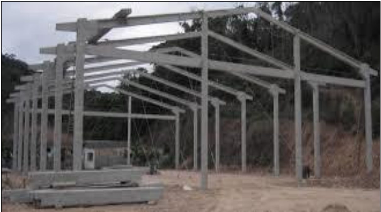
Figura 9 – Exemplo de estrutura de um “galpão” pré-moldado
