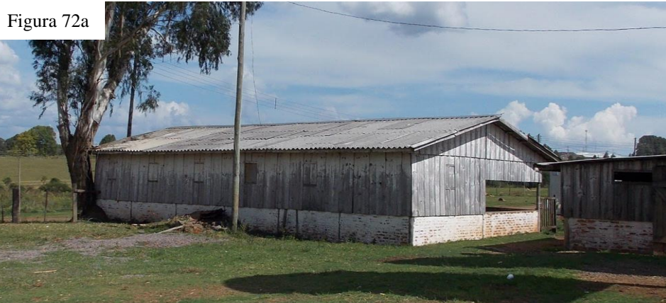
Figura 72 – Edificações precárias na área de acampamentos campeira
