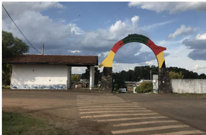
Figura 64 – Atual pórtico de acesso principal do parque
