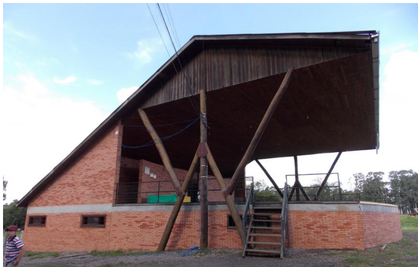
Figura 67 – Estrutura do palco e apoio da Concha Acústica
