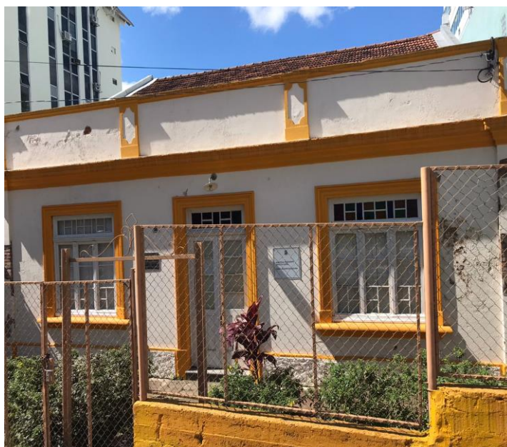
Figura 11 - Fachada da Casa Geisel
