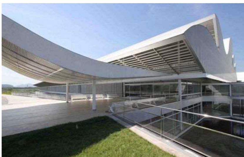
Figura 28 – Sistema para a entrada de ventilação natural
