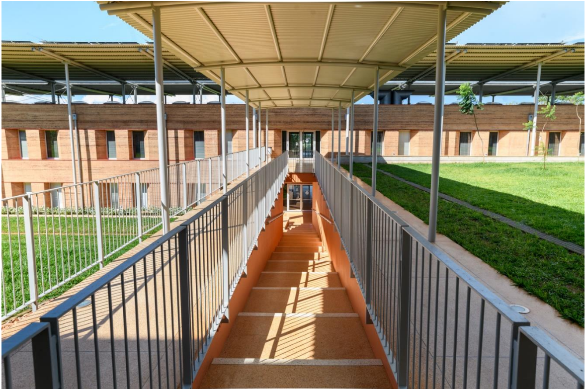
Figura 29 - Acesso entre blocos, com passarela e escadarias
